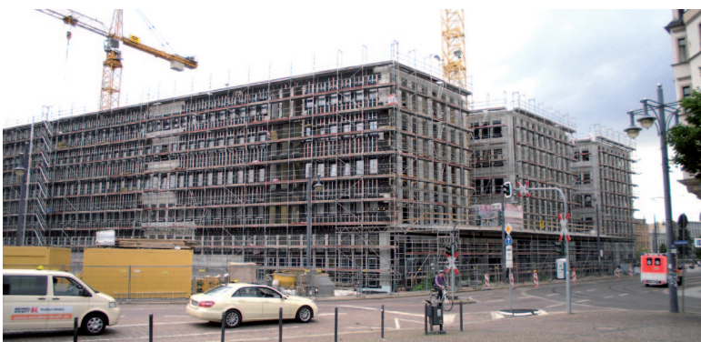
Abb. 2: aktueller Baufortschritt, Juli 2015
